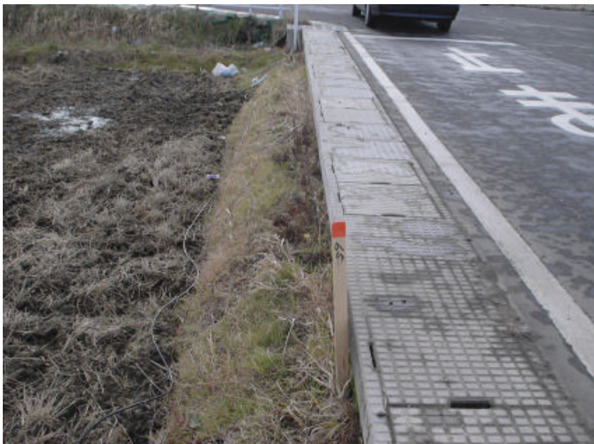
写真 20 受振器設置の様子
