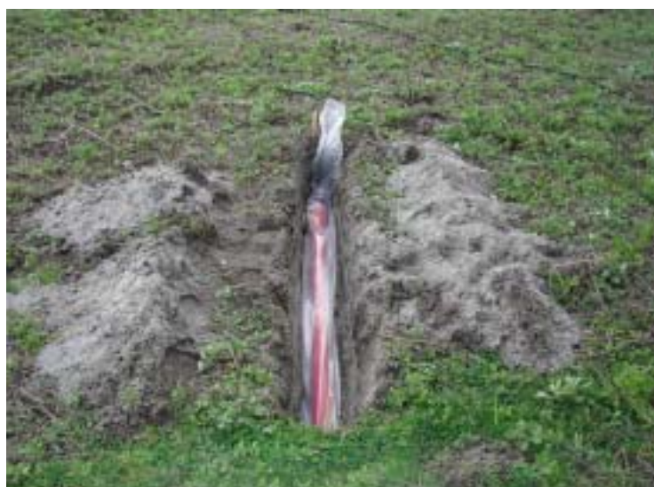
MT-2 水平コイルの埋め込み
