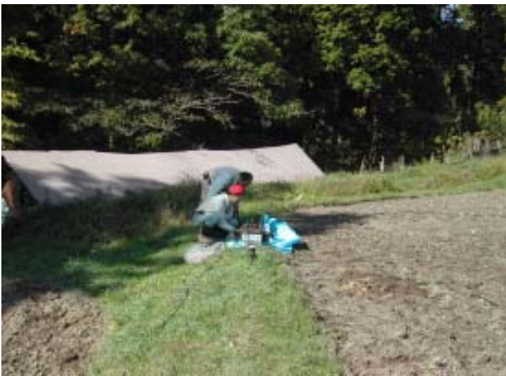
MT-11 観測装置設置作業
