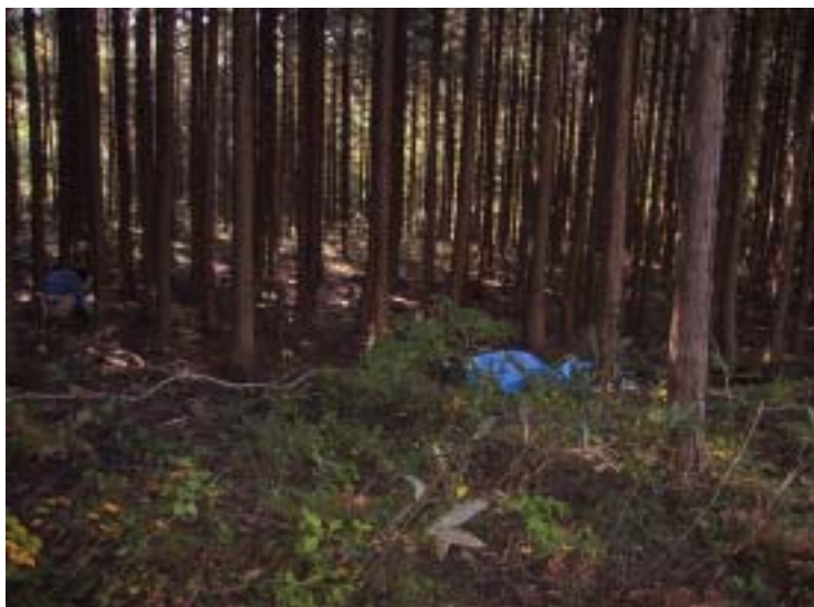
MT-9 観測装置設置作業
