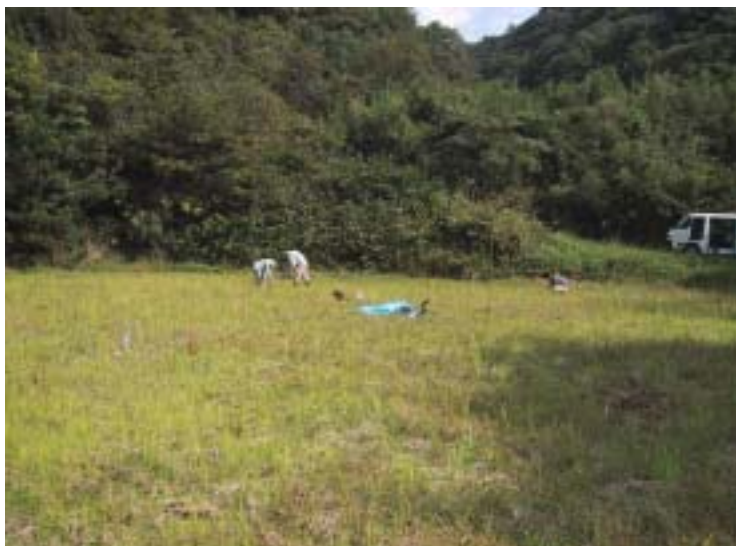
MT-5 観測装置設置作業
