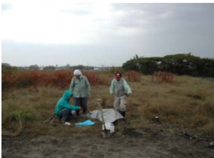
MT-3 観測装置設置作業
