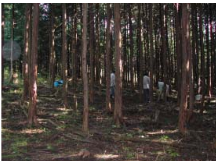
MT-9 観測装置設置作業
