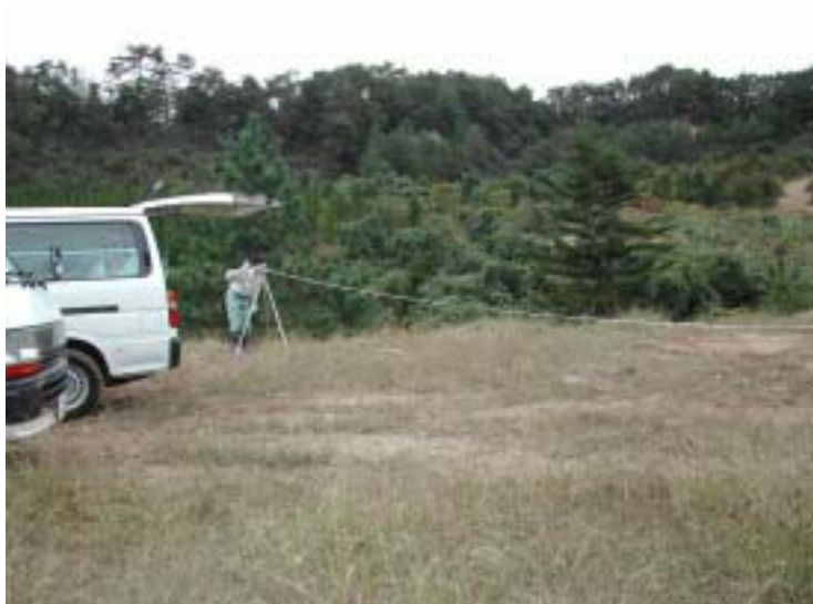
MT-7 観測装置設置箇所 測量
