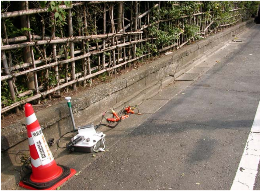
MS-2000 Line 受振器設置状況
