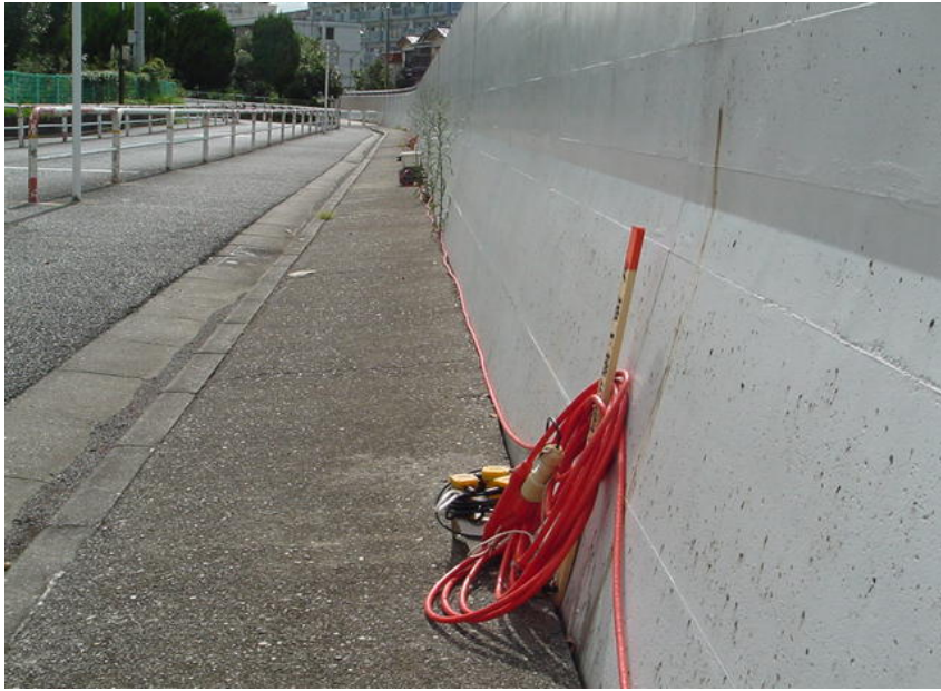
Line-1 受振器設置状況
