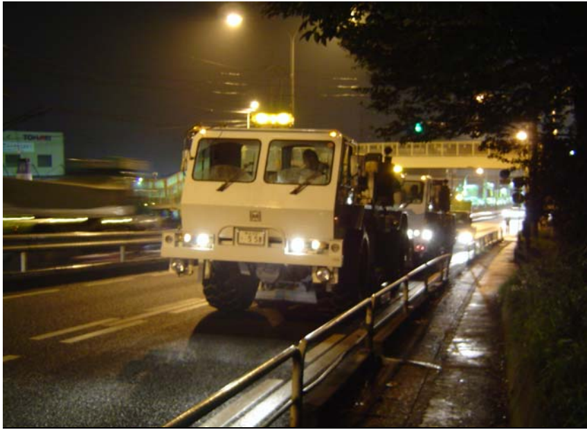
夜間発震作業状況
