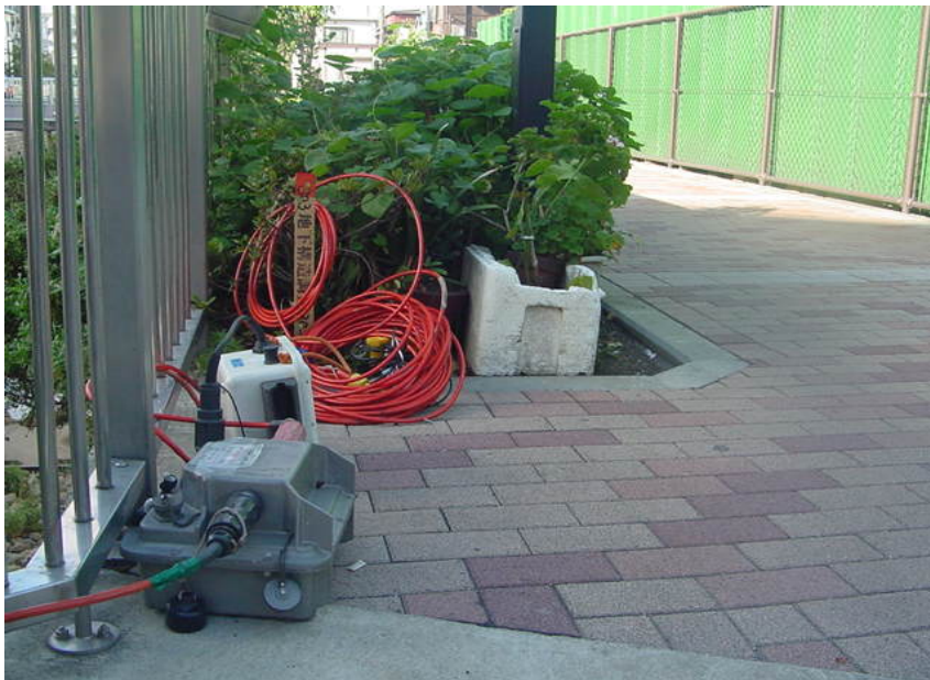
Line-1 受振器設置状況
