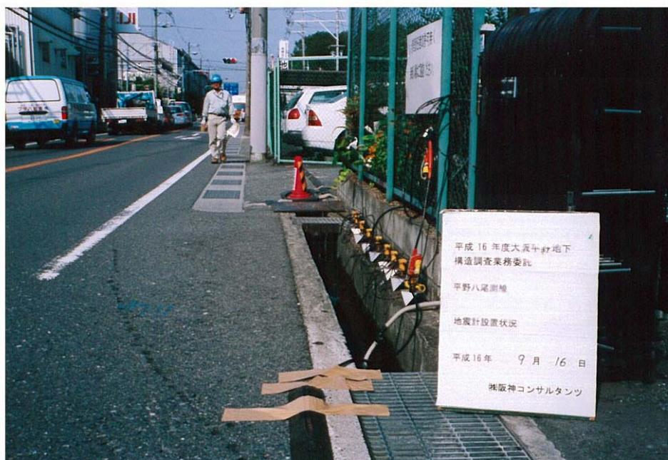
写真-6 地震計設置状況（アスファルト舗装部）
