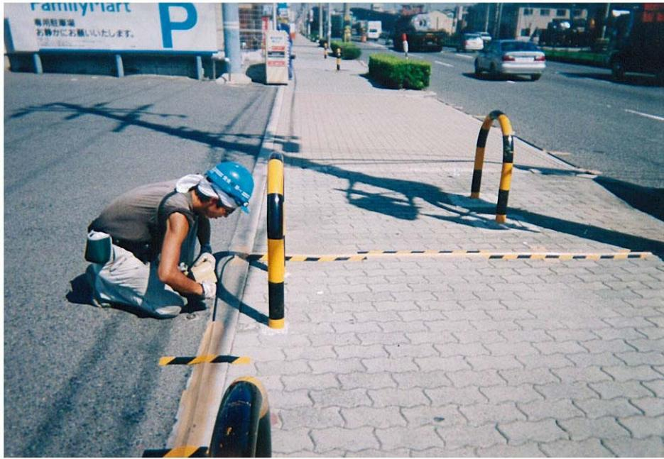
写真-19 受振器材設置状況
