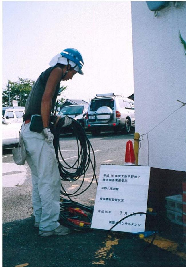
写真-3 受振器材設置状況(CMP105 付近)
