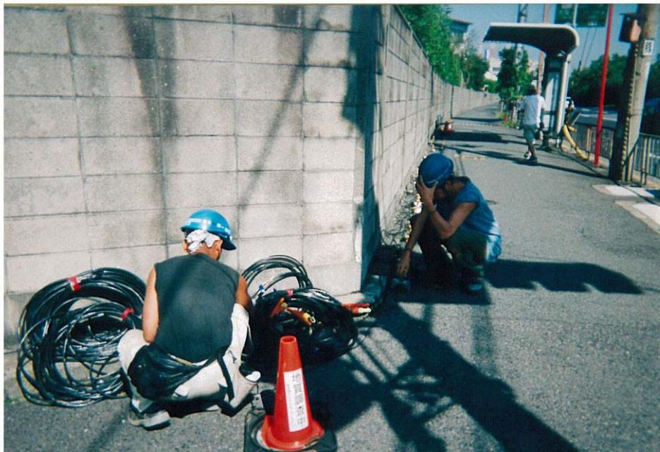
写真-18 受振器材設置状況(CMP1570 付近)
