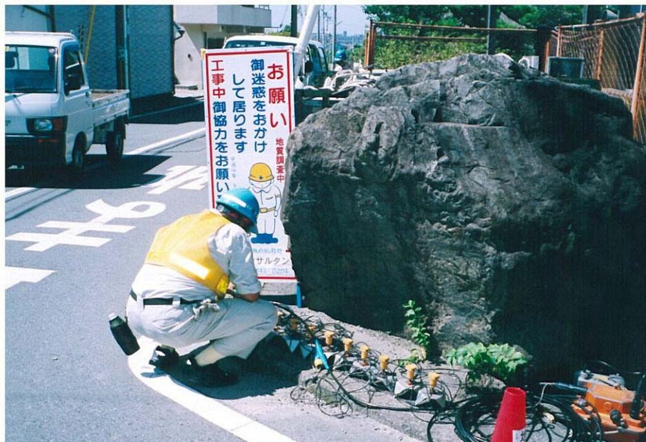
写真-4 受振器材設置状況(CMP614 付近)
