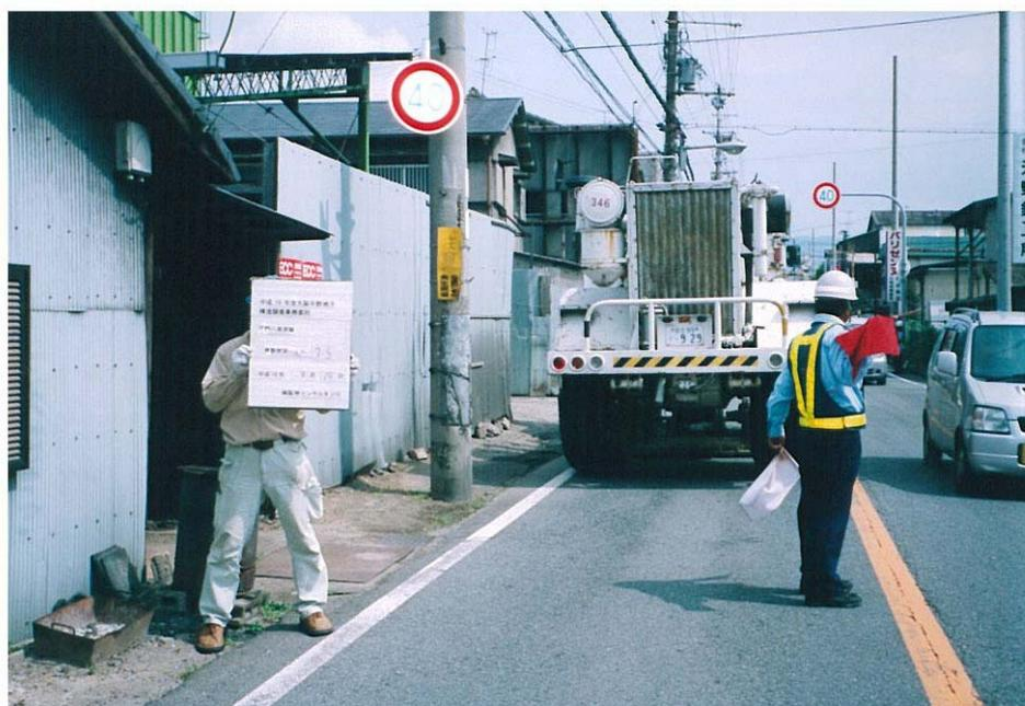
写真-10 CMP140 付近におけるバイブレータによる発震状況(測点 75 付近)
