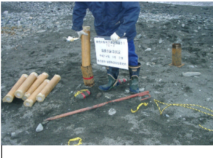
TD3 (酒匂川) 爆薬装填作業 (海底発破用爆薬1号)
