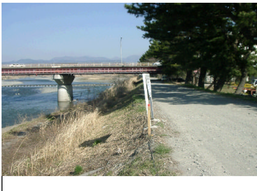
受振器設置状況 B測線RP136
