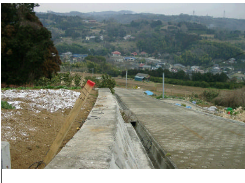
受振器設置状況 A測線RP1 13
