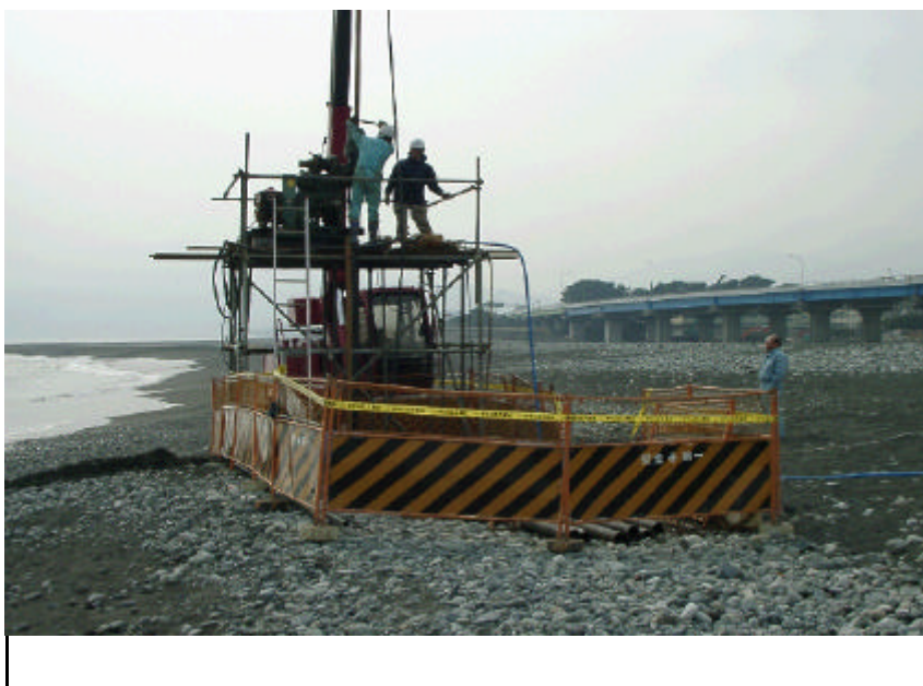
TD3 (酒匂川) 掘削中の状況
