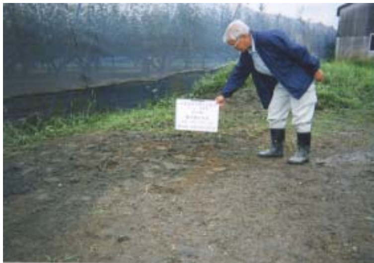
D3 復旧後の状況
