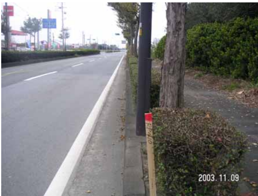
図Appendix1-9 現地調査写真(9) 豊橋平野RP-410(豊橋市問屋町)
