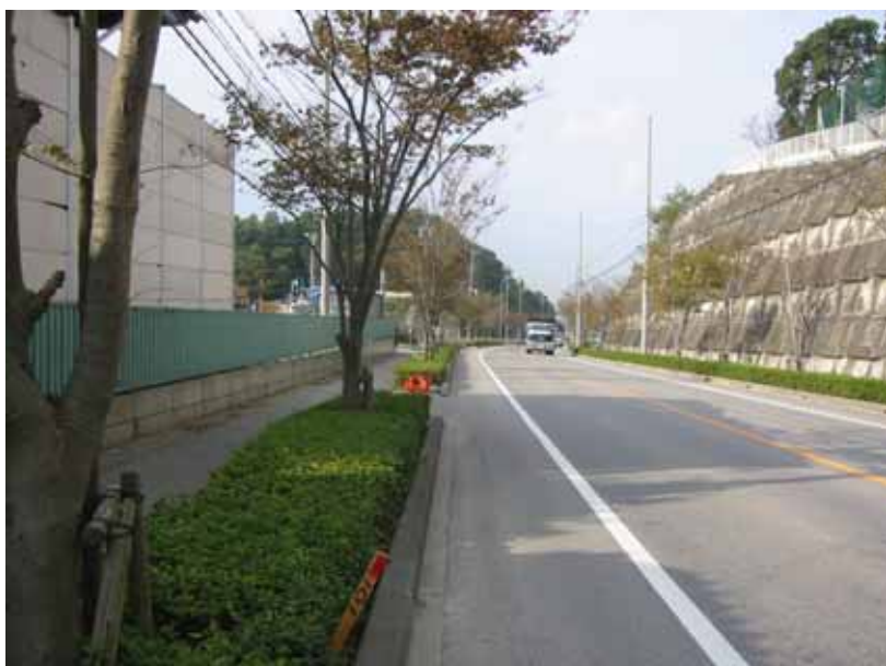
図Appendix1-1 現地調査写真(1) 岡崎平野 Loc.101 幡豆郡吉良町
