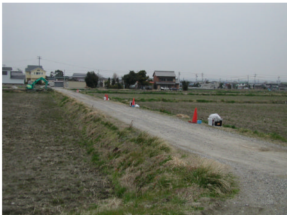
〇 - 8 Sアレー地震計設置状況
