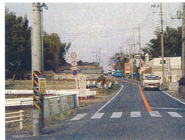
写真-18 測線B池部町付近、道路改良拡幅工事にともなう用地が確保されている。
