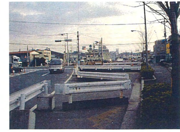
写真-19 測線B南端、道路改良拡幅工事にともなう用地が確保されている。
