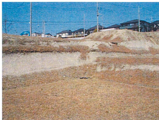
写真-1 多摩丘陵宅地切土に露頭する上総層泥岩
