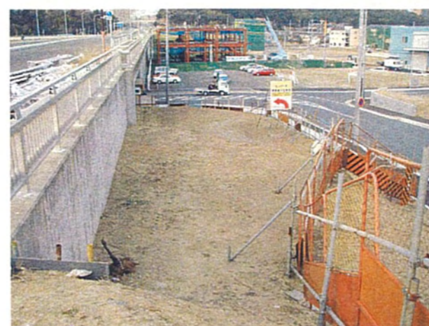
写真-16 センター南駅近く、道路橋の橋台脇
