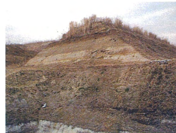
写真-6 センター北駅西側の露頭
