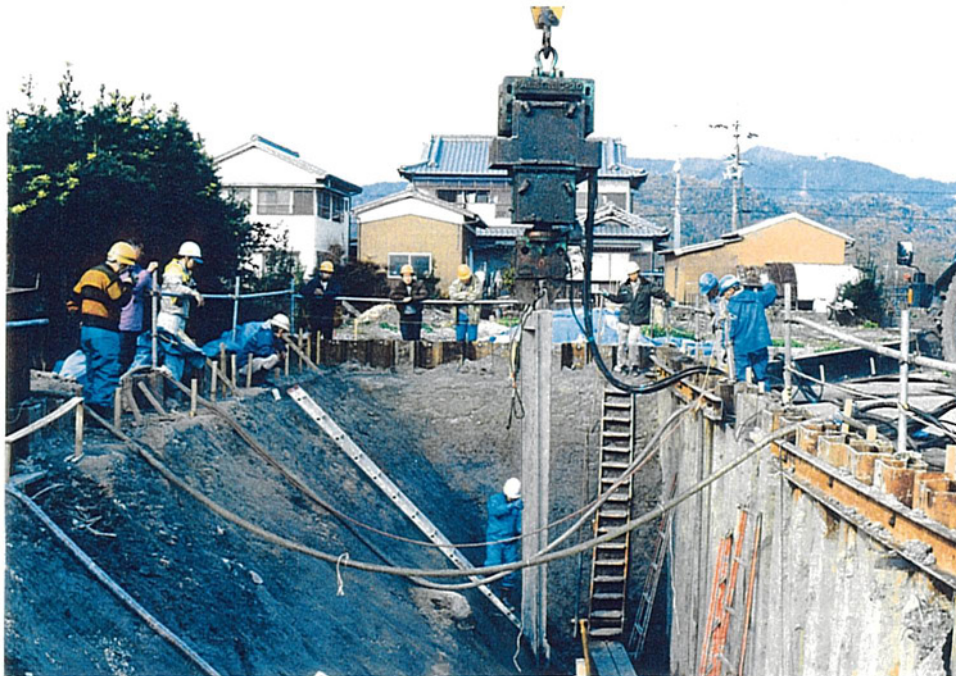
写真－15 トレンチ底から実施した Geo-Slicer. パイプロハンマーで打ち込んでいる 状況.
