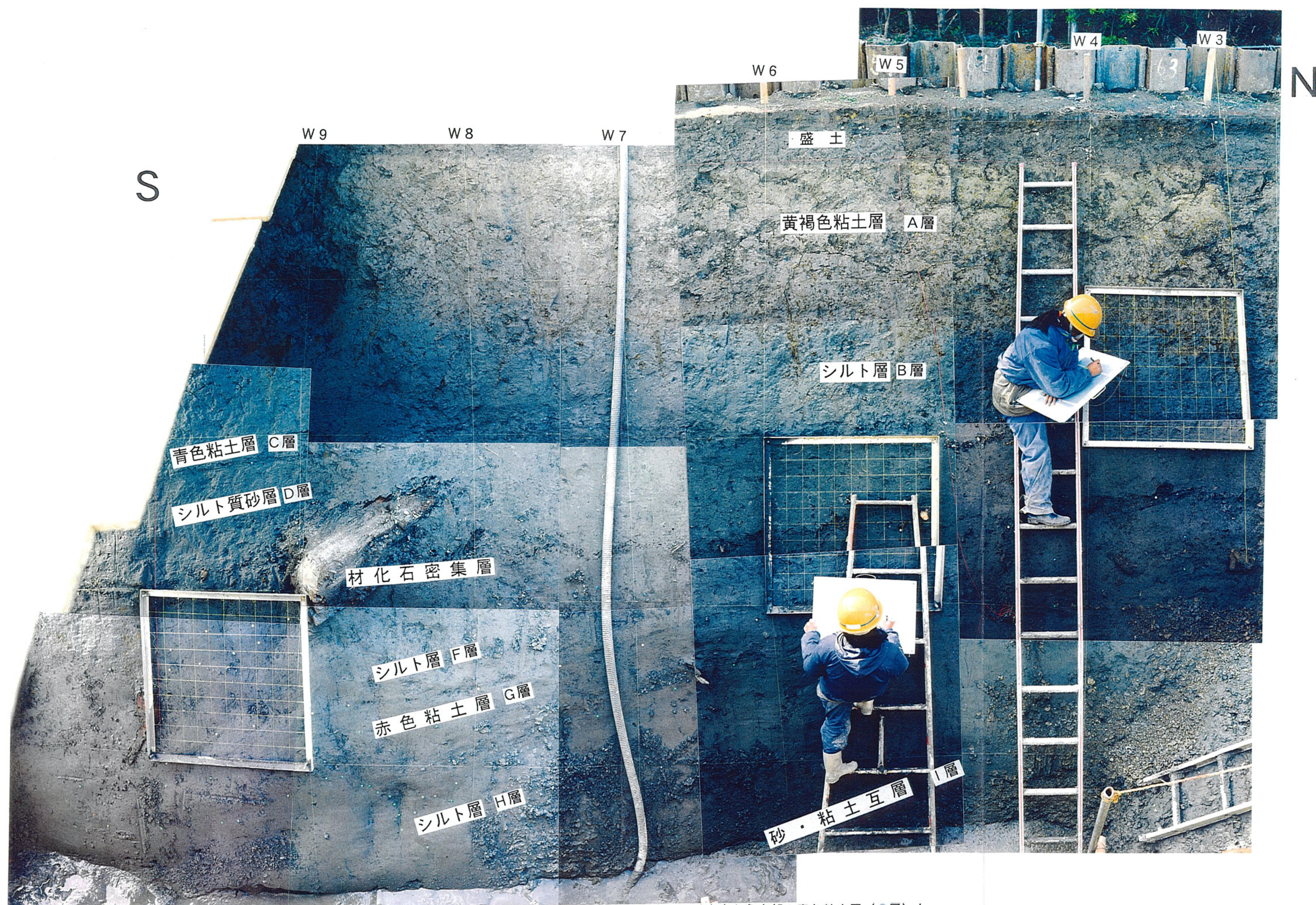
写真-1 トレンチ壁面の写真。右側が北で左側が南。トレンチ中央から上部の青色粘土層（C層）とシルト質砂層（D層）は緩やかな撓みがみられるものの、ほぼ水平に堆積している。下部のシルト層（F層、H層）、赤色粘土層（G層）、及び砂・シルト互層（I層）は約 10° 南側に傾斜しており、C層・D層とF層～I層は傾斜不整合の関係にある。下部のF層～I層はW9～W10付近で折れ曲がり、それから南側では水平になっている。傾斜不整合上部のC層・D層もW8～W11付近で撓みがみられる。
