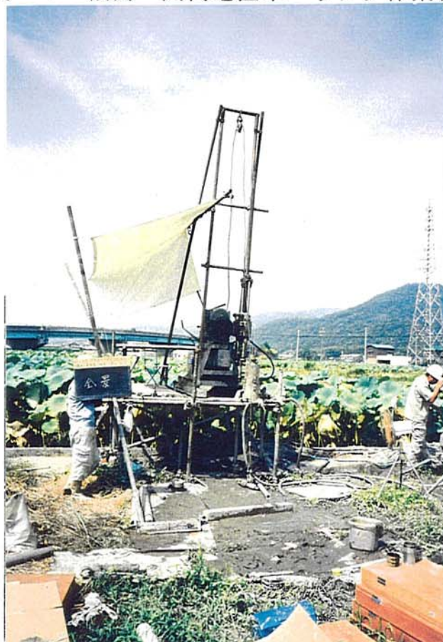
写真－２ 姫田地区ボーリング作業状況
