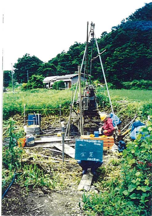
写真－3 川端地区ボーリング作業状況
