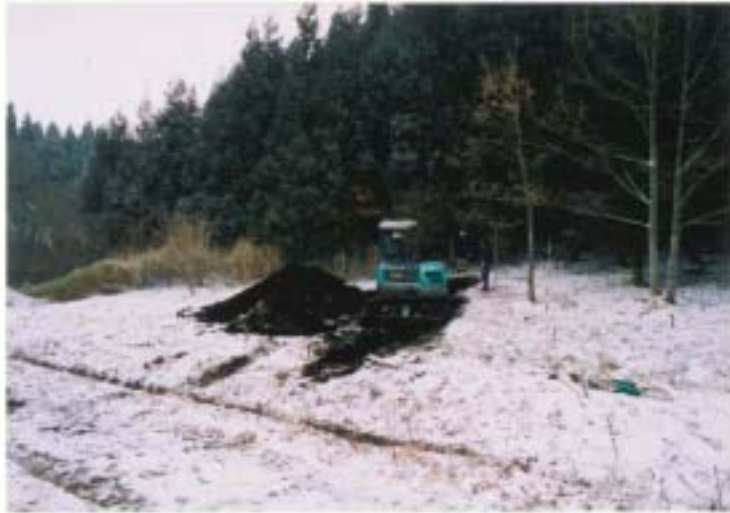
トレンチ掘削作業
