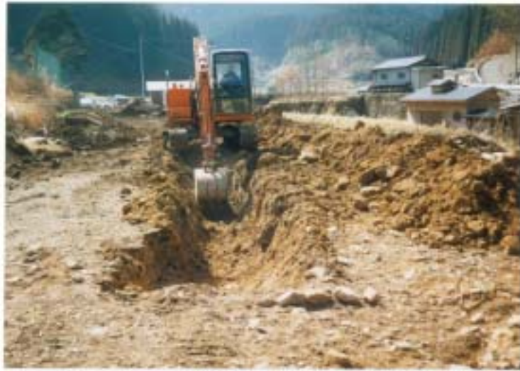
トレンチ掘削作業
