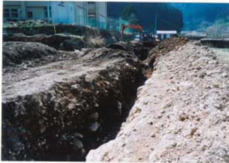
トレンチ掘削作業 (追加掘削)
