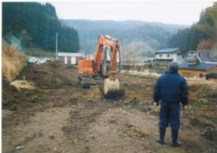
トレンチ掘削作業
