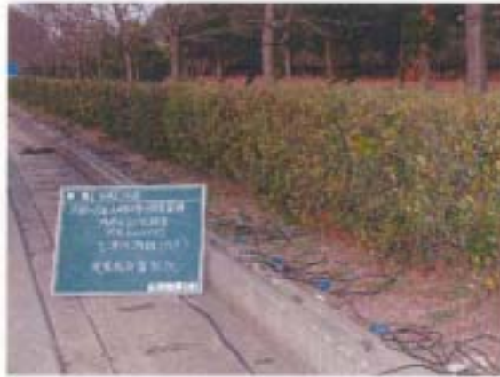
受振器設置状況(P波)
