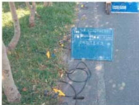
受振器設置状況
