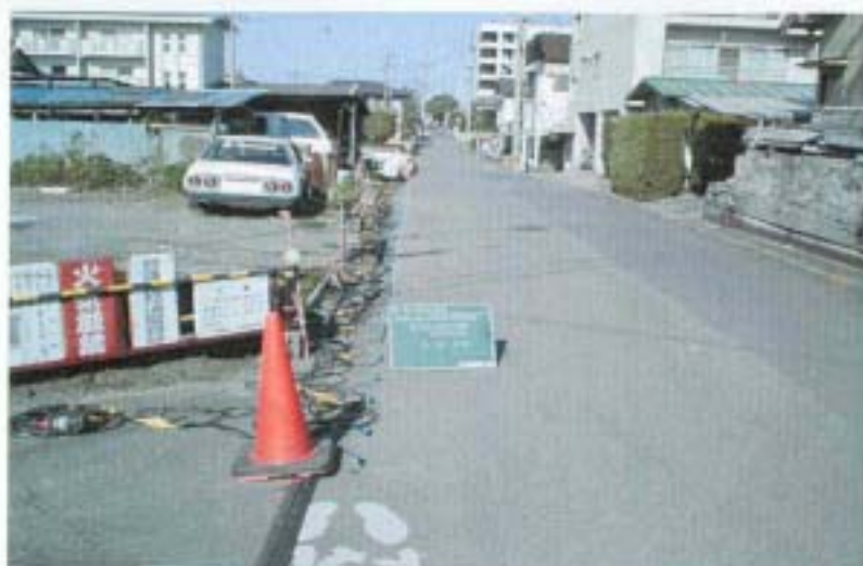
測線展開状況・日岡地区測線
