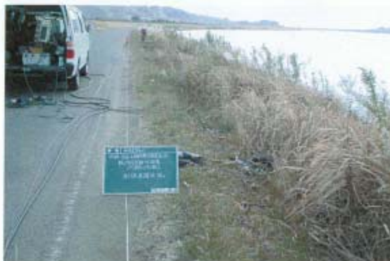
測線展開状況・大野川測線
