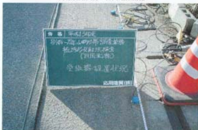
受信器設置状況・日岡地区測線
