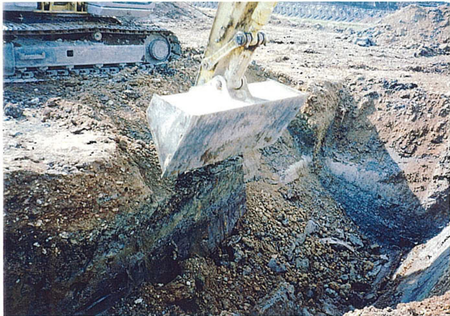
トレンチ本掘削
