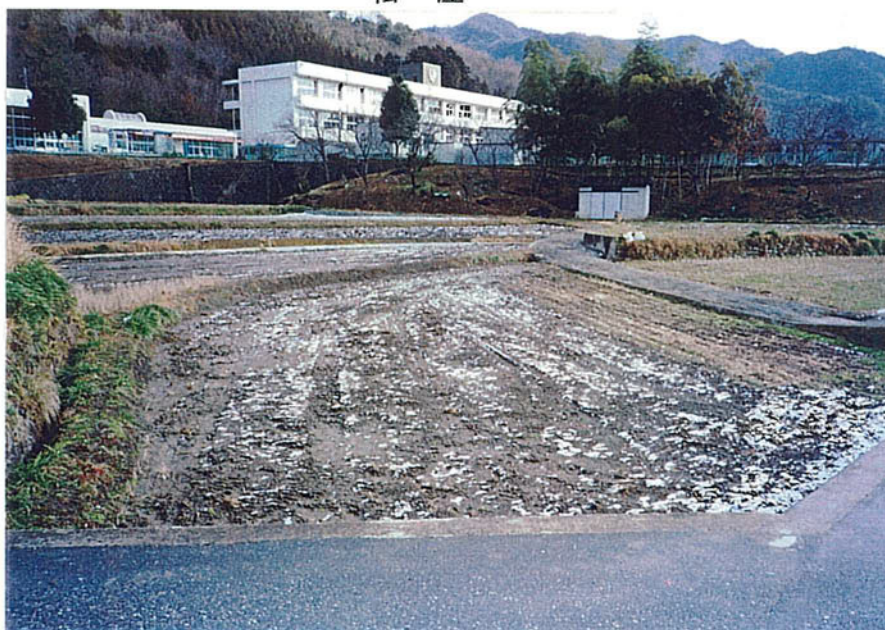
埋め戻し完了
