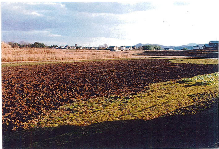
埋め戻し完了
