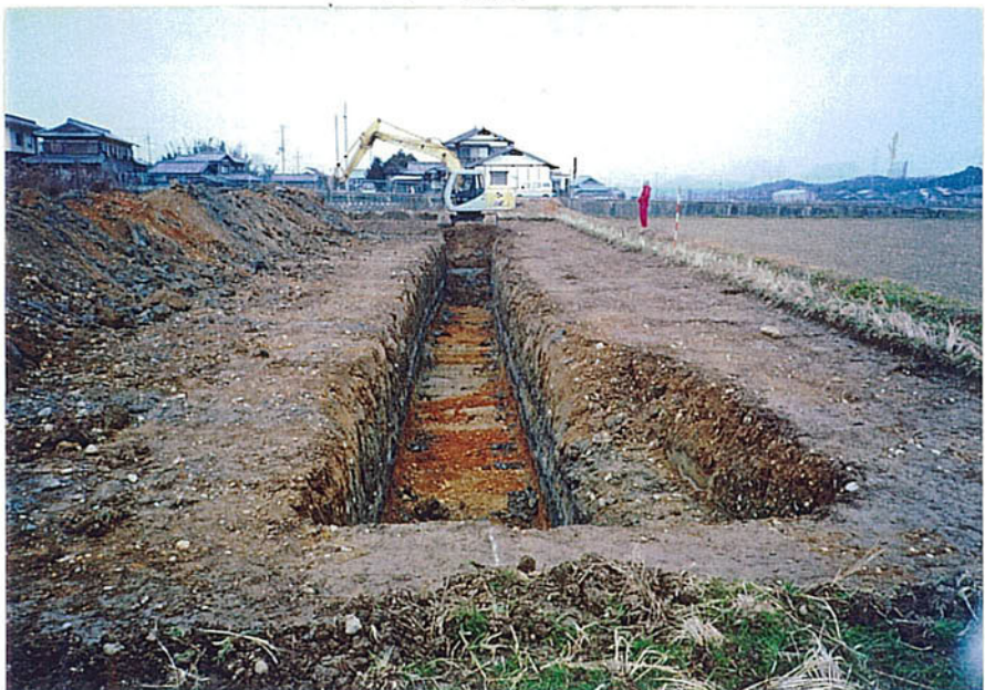
ピット掘削全景
