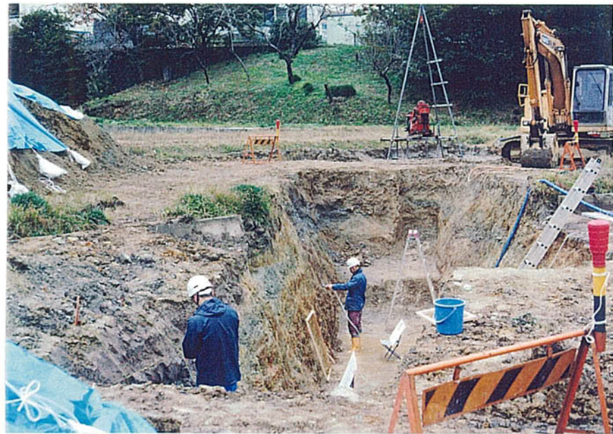
壁面観察状況
