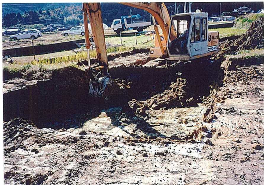
トレンチ本掘削
