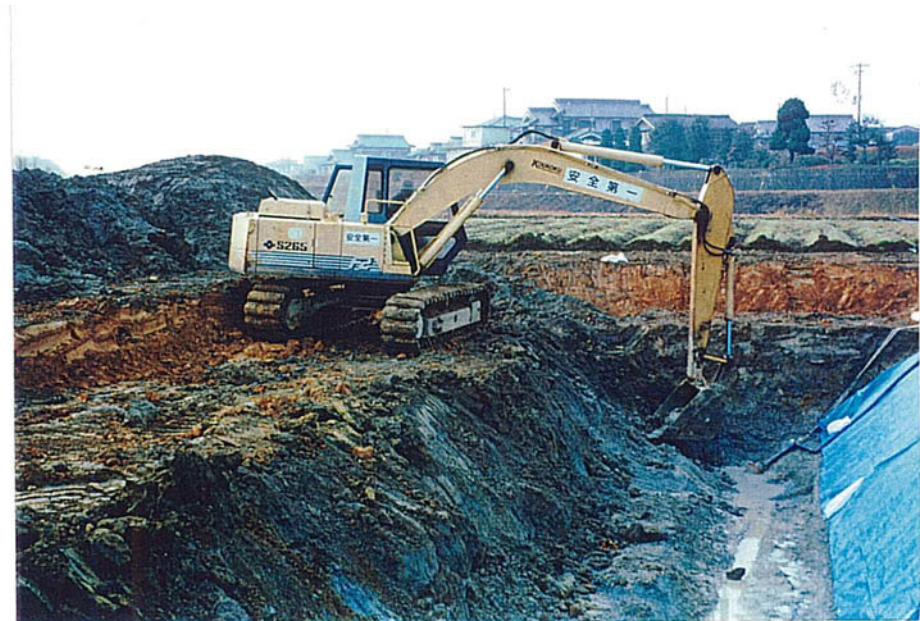
トレンチ本掘削
