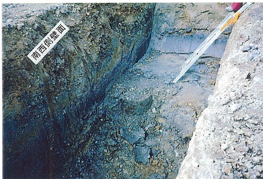
井戸の遺構付近の壁面（掘削長さ42m付近）
