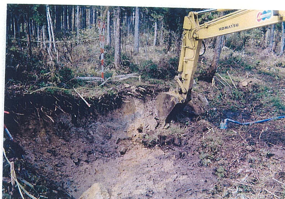
掘削作業状況
