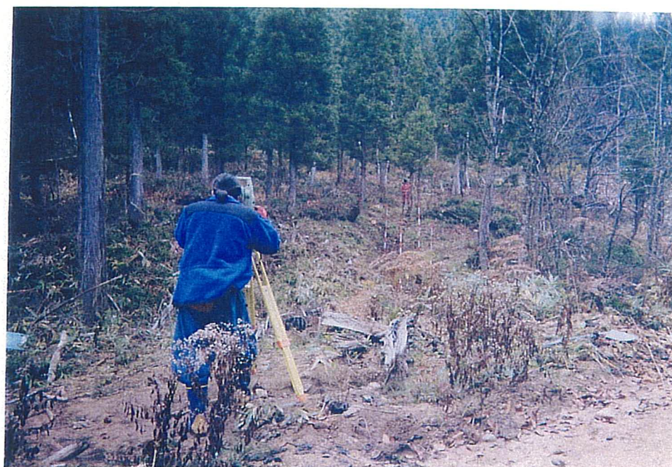
測量状況写真
