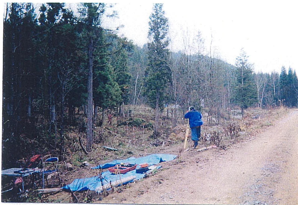
測量状況写真
