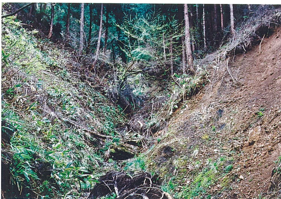
写真11-3 右横ずれ屈曲している 小沢と谷底の断層破碎帯
