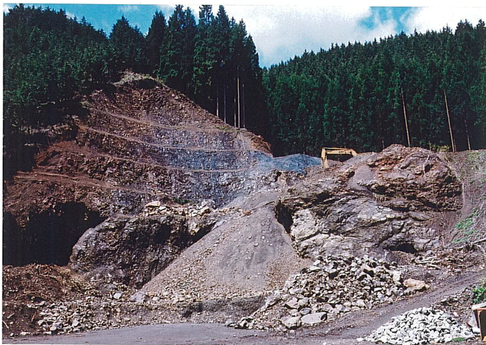
写真11-4 典型的な美濃帯の 緑色岩の露頭 写真中央重機の左側が 写真11-5の断層破碎帯
